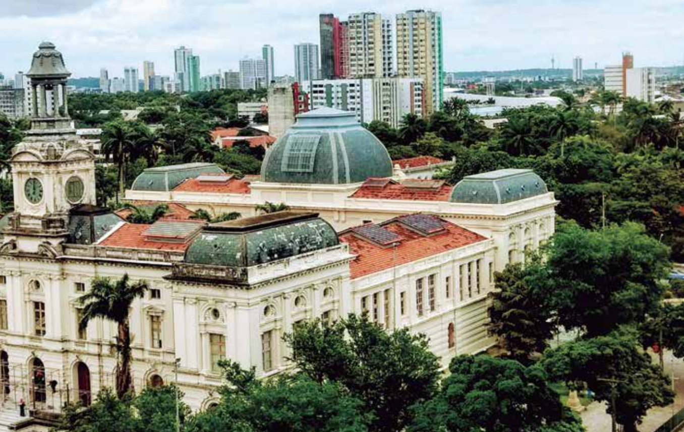
O prédio da Faculdade de Direito de Recife.
